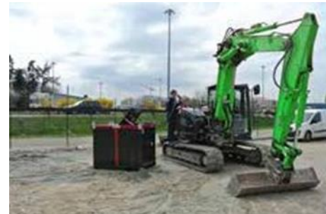
MOVIMIENTO DE TIERRA
